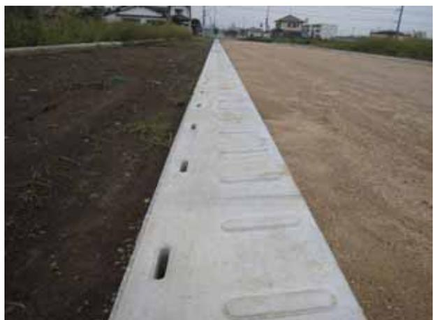
「あんしんバリアー工法」とは、走行車線から逸脱したドライバーに危険を知らせる、「振動(バイブレーション)機能付の側溝」を用いた「交通事故防止技術」です。
